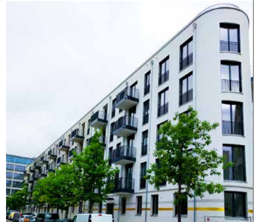
Ein Wohnungsbauprojekt in der Englischen Straße in Berlin. Innerhalb von acht Monaten montierte die EGE Holzbau GmbH hier 1.557 Holzfenster, darunter 1.200 in RC2 und 200 in RC3. Foto: EGE Holzbau
